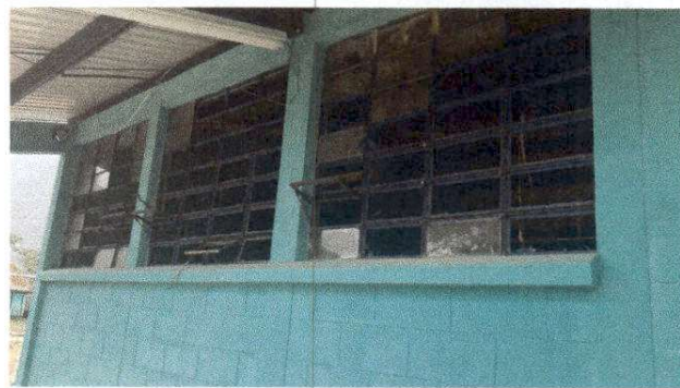
Foto 2: Sustitución de estructura de metal de ventana.
