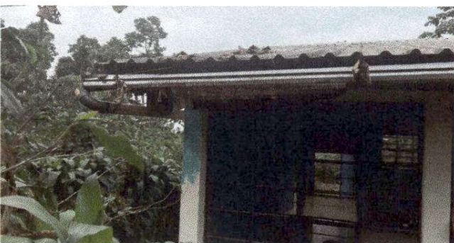
Foto 3: Sustitución de canal de metal. 7.3 Reparación de bajada de agua pluvial, tubo PVC 3".
