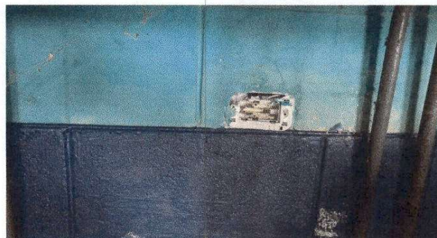
Foto 8: Sustitución de tomacorrientes dobles
