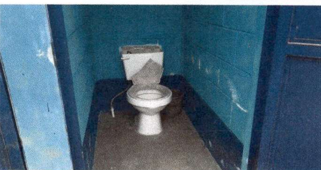
Foto 5: Sustitución de accesorios inodoro ( contra llave, tubo de abasto y tanque) Sustitución de tapadera sanitario.
