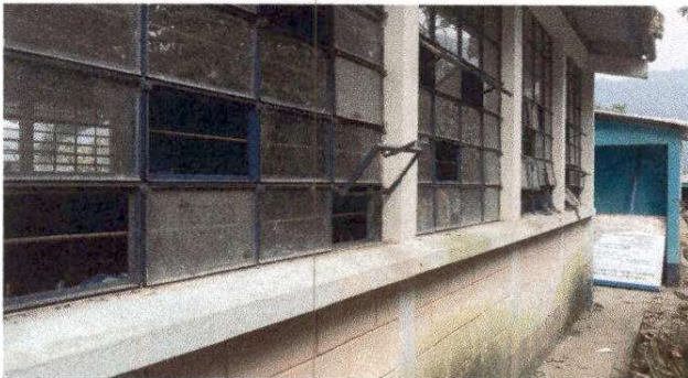
Foto 4: Pintura en muros exteriores e interiores
