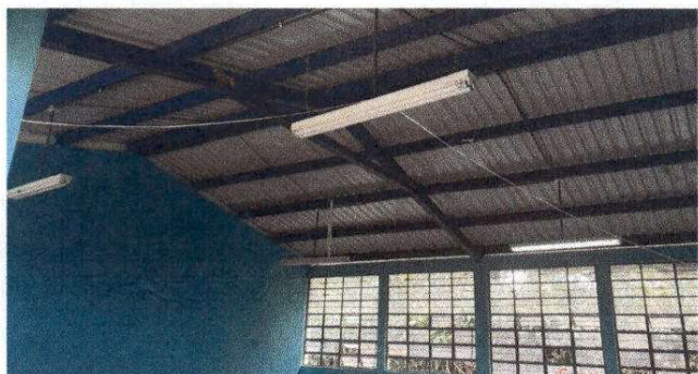
Foto 7: Sustitución de focos ahorradores. Reparación de cableado eléctrico.
