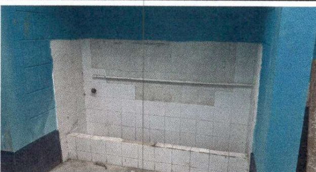
Foto 6: Sustitución de azulejo.
